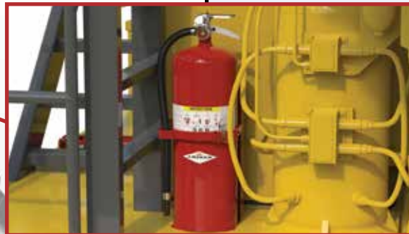
Extintor de Alto Flujo
